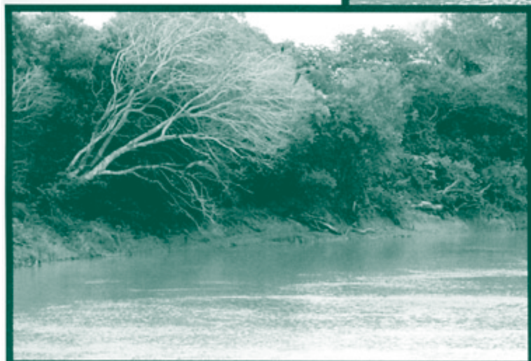
FOTOGRAFIA 6.12: DANOS ÀS MARGENS PRODUZIDOS POR EMBATE DOS COMBOIOS
