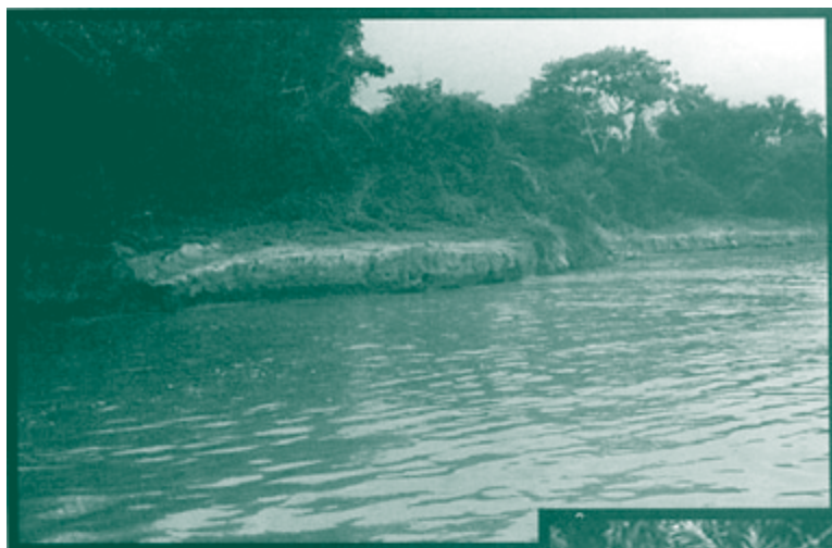
FOTOGRAFIA 6.17: DANOS AS MARGENS PRODUZIDOS POR EMBATE DOS COMBOIOS
