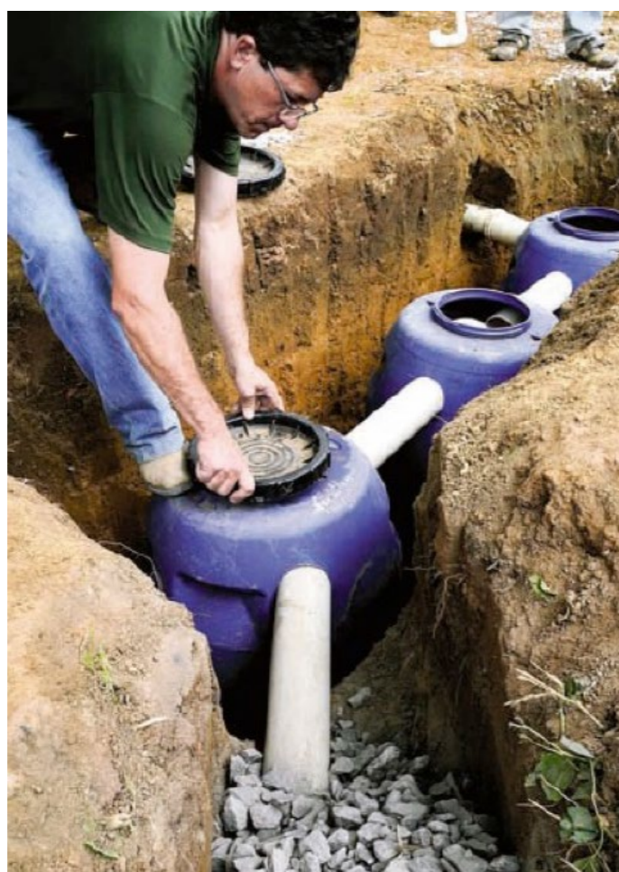
Figura 17. Instalação de fossa séptica econômica
