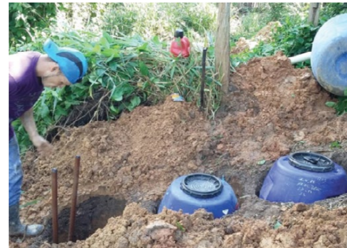
Figura 12. Instalação de fossas sépticas econômicas, como parte de ação de Saneamento Básico na bacia do igarapé Santa Rosa
