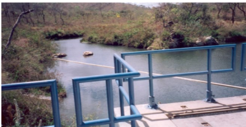
Figura 5. Barragem de derivação do Sistema Pípiripau (Caesb)
