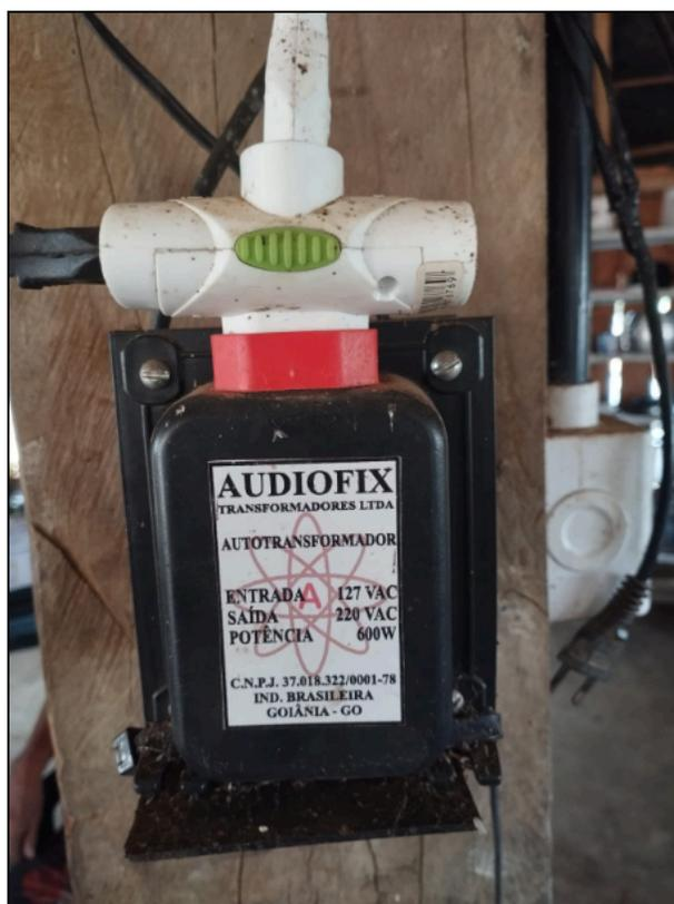
Figura 7. Transformador 127/220 V instalado nas residências de madeira e palha da Aldeia Khikhatxi.
