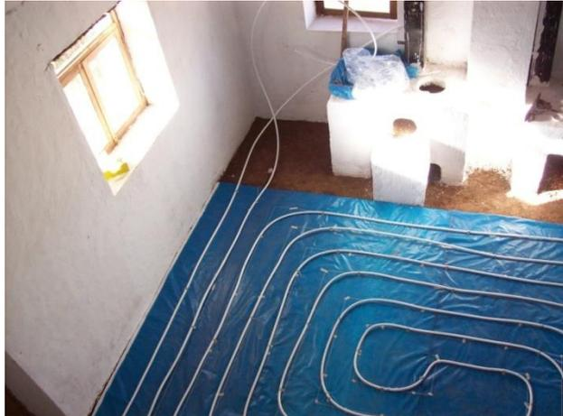
“Diseño de un Suelo Radiante de 12m<sup>2</sup> para una Sala Ubicada a 4000 msnm en Langui-Cuzco”
