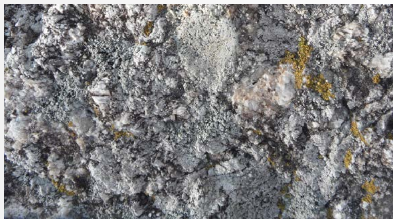
Camuflagem com durepoxi de buraco de uma proteção fixa que foi substituída (Kika Bradford)
