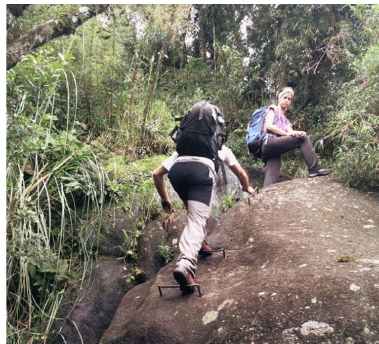
Colocação de degraus na rocha, direcionando o tráfego de pessoas para longe da vegetação no Parque Estadual do Anhangava, Paraná (Brasil)
