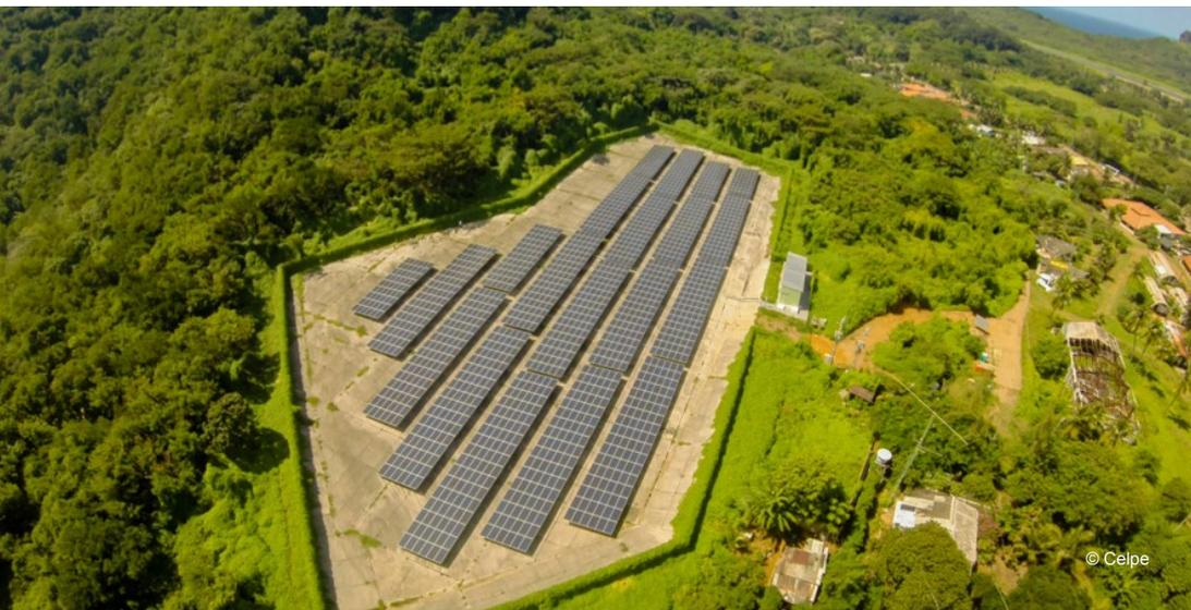
**FIGURA 4. Usina Solar Noronha II sobre uma laje de captação de água da chuva**
