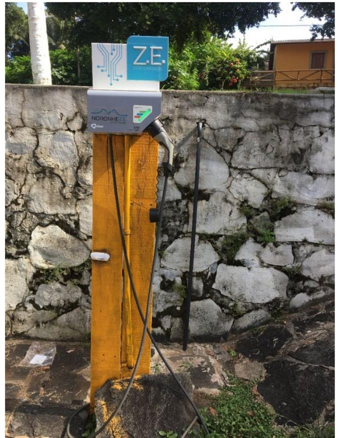
**FIGURA 3.** Um dos postos simples de recarga de Noronha conectados à rede elétrica para abastecer os veículos elétricos já existentes na ilha
