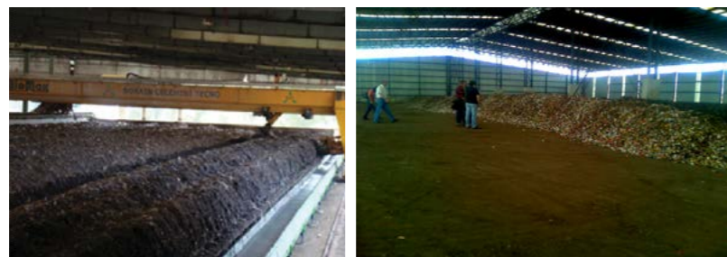
Figura 16: Instalação em Barcelona, Espanha, e em S.J. Rio Preto/SP, operando em pátio fechado
