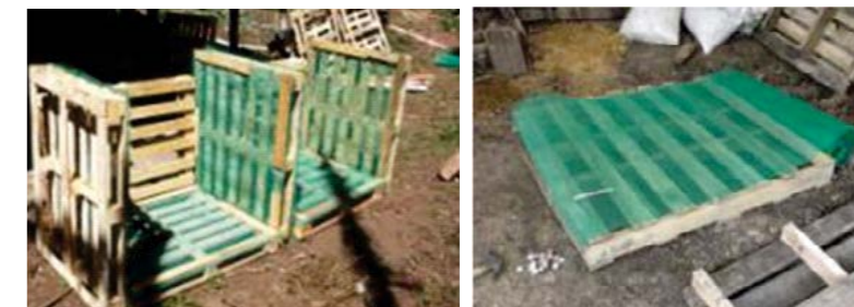
Figura 39: Colocação da tela nos paletes
