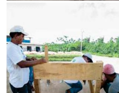
Figura 48: Montagem das baias
