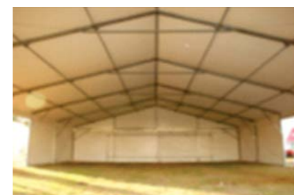
Galpão cobertura têxtil
