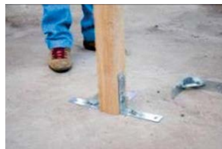
Figura 46: Montagem de baias piloto em Rio Branco/AC.
