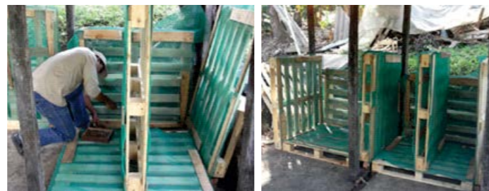
Figura 40: Execução dos compartimentos e fixação das portas.
