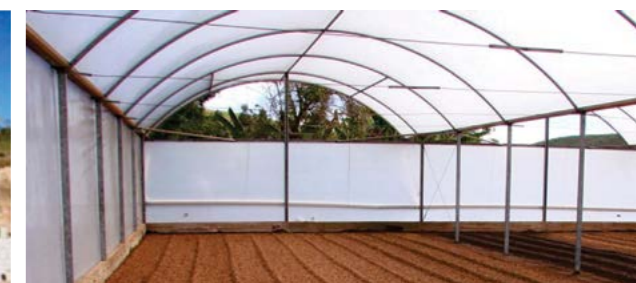
Galpão leve em lona plástica
