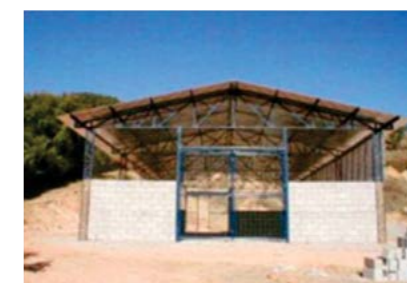
Galpão em estrutura metálica
