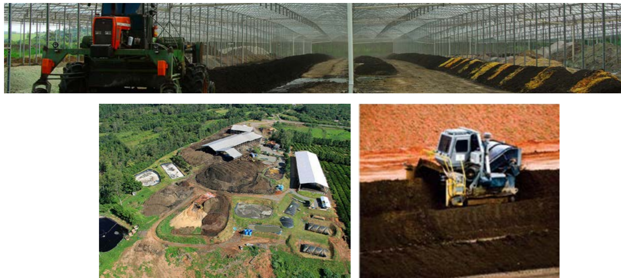
Figura 15: Instalações da Tera Ambiental (Jundiaí/SP); da Ecocitrus (Montenegro/RS) e da Geociclo (Uberlândia/MG).
