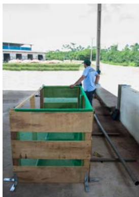
Figura 50: Preparação do sistema de aeração forçada
