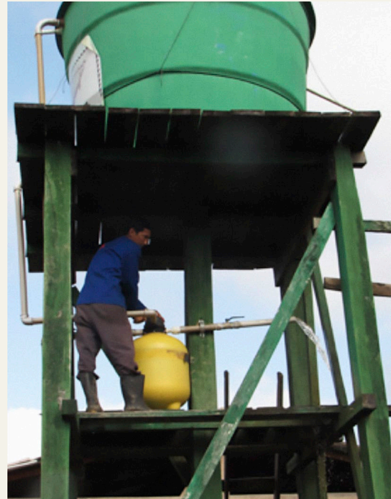
Foto 6 – Sistema de filtração de água de superfície (rio). Fonte: Usinazul, 2015. Reserva Mamirauá.
