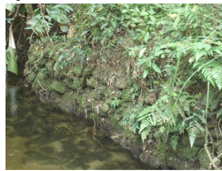
Figura 7 - Estrutura de Ponte
